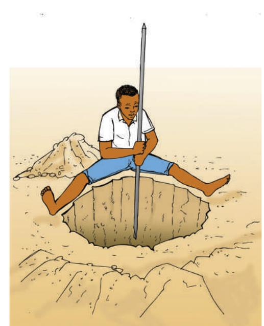
C'est un trou de 90 cm de diamètre qui doit traverser et dépasser la couche de latérite sous celle de la terre arable. La profondeur variera de 1 à 5 m en fonction de la profondeur de la latérite. Si en creusant on atteint à 1 m la terre tendre sans tomber sur la latérite on arrête de creuser.
