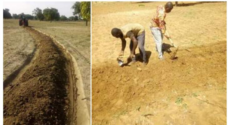
Réalisation des diguettes en terre sur les courbes de niveau/ WV
